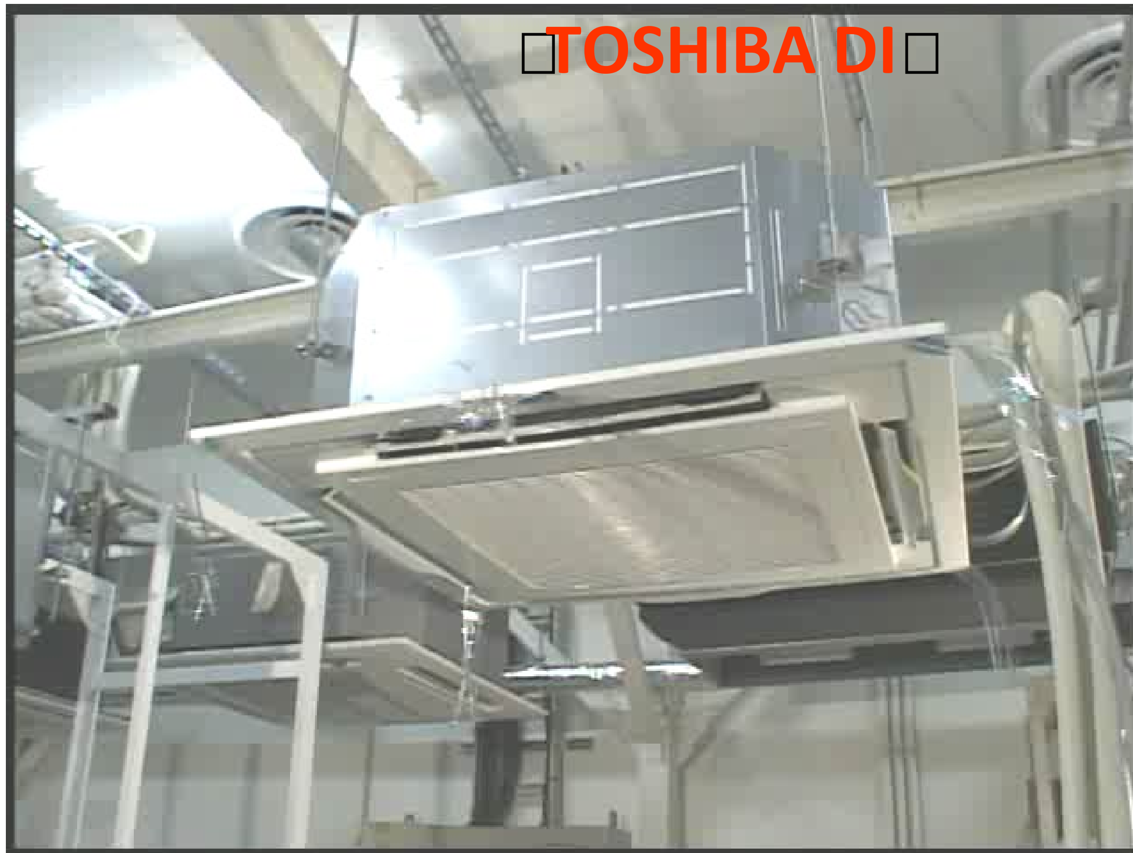
Vzduch proudí z jednotky HORIZONTÁLNĚ
